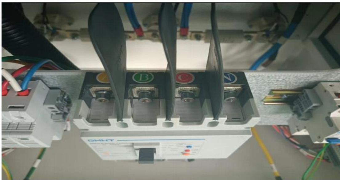
Obrázek 5-4-1 Schéma připojení kabelu nabíjecí stanice pro elektromobily
