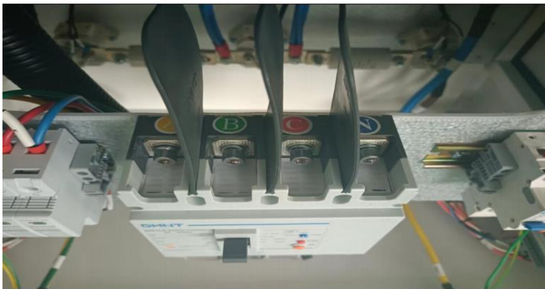
Obrázek 5-4-1 Schéma připojení kabelu nabíjecí stanice pro elektromobily
