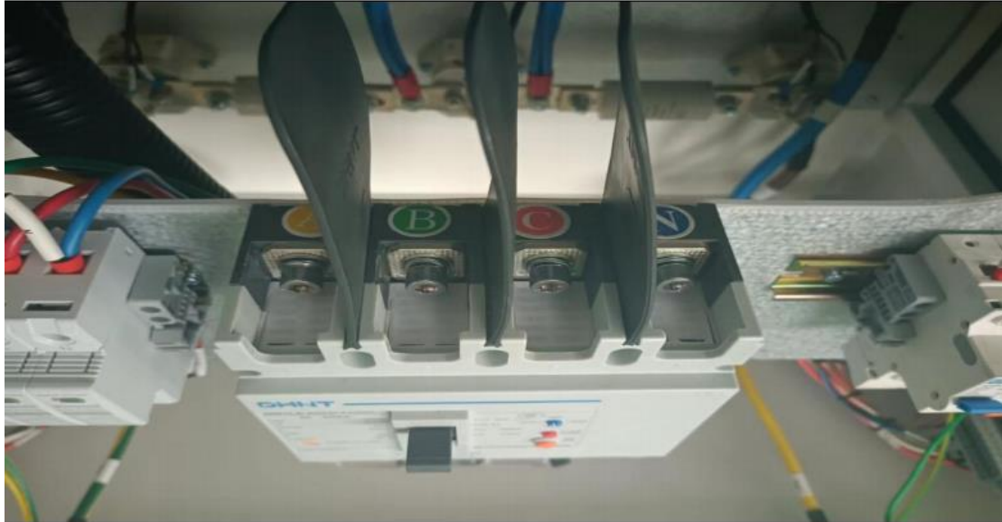
Obrázek 5-4-1 Schéma připojení kabelu nabíjecí stanice pro elektromobily
